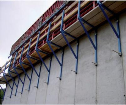
Aprovechando el muro que hemos hormigonado sujetaremos haciendo coincidir los pasos de varillas divididas existentes sobre las cuales apoyaremos los paneles para el siguiente hormigonado. Dichas ménsulas también sirven para soportar los puntales de nivelación y como apoyo para las plataformas de trabajo para los operarios.
