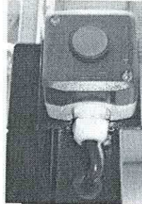
Fig. 39 Boton descenso Montacargas a la posición "0".
