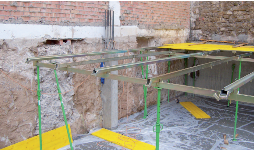
Comienzo de montaje desde una esquina.
