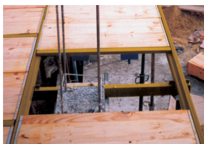
Detalle de la Sopanda en su posición con la Guía debajo marcando la calle.
