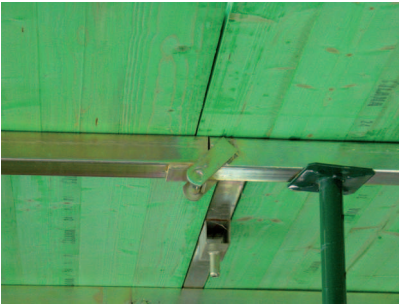
Detalle de unión con otra Sopanda así como la posición del puntal.
