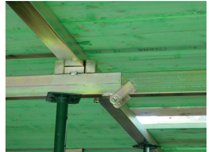
Detalle de unión con otra Guía así como el alojamiento de la Sopanda y la posición del puntal.
