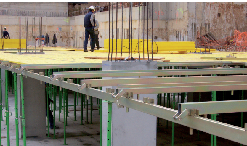
Detalle de posicionamiento de las Sopandas e Intermedios en los alojamientos de las Guías.
