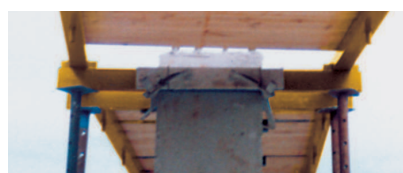
Detalle de la Guía posicionada al pilar .
